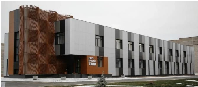
Волжский Трубный Завод (Группа ТМК) Административно-лабораторный комплекс Эко Хаус
