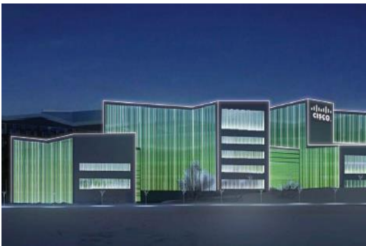
Комплекс зданий «Мэйджоры» (сертифицируется как 2 отдельных LEED проекта), ИЦ Сколково, Москва
